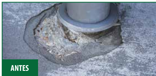
Novolite Repair Mortar usado en concreto.
